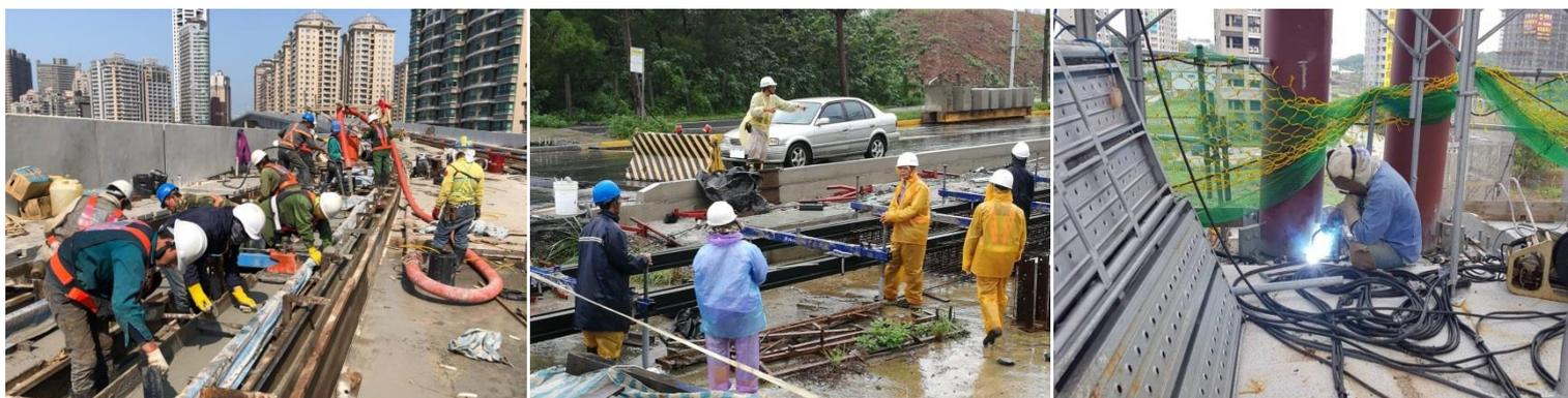
道床版澆置、道岔組立鋼軌下架調整、車站鋼構銲接〈圖片摘自 OPEN33 網站〉
